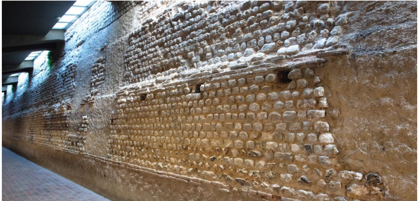
Vue des vestiges du rempart gallo-romain depuis le sous-sol du musée.
