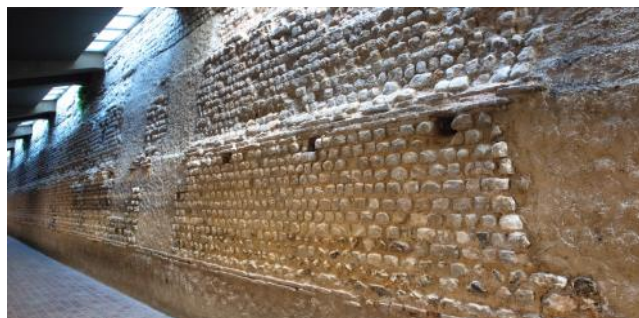
Vue des vestiges du rempart gallo-romain depuis le sous-sol du musée.
